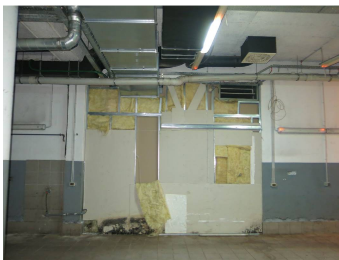
zid zatvoren gipskartonskim plačama
